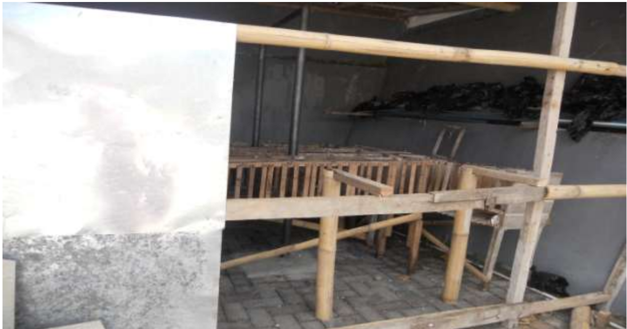
Pekerjaan Kandang Ayam Buras
