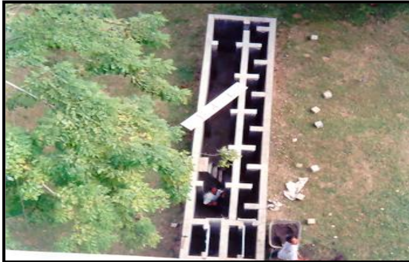
Gambar 9. Pembangunan instalasi ABSAH
