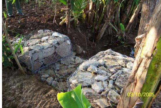
**Gambar 7.** *gully plug* sederhana.
