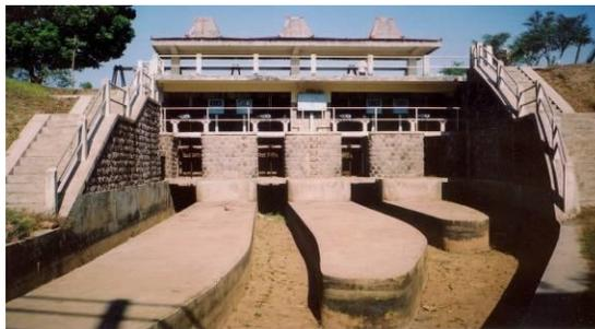
**Gambar 4. Bangunan Intake yg tidak lagi berfungsi**
