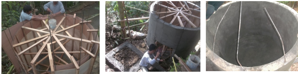
Gambar 3. Pembuatan Cetakan Digester Tipe fixed dome di Atas Tanah
