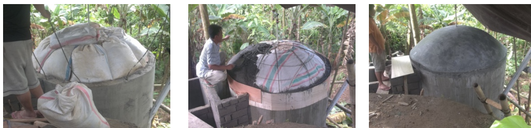
Gambar 4. Pembangunan Kubah Digester Tipe fixed dome di Atas Tanah
