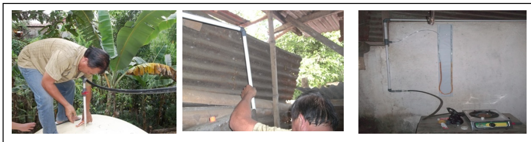
Gambar 6. Pemasangan Instalasi dari Digester Tipe fixed dome di Atas Tanah
