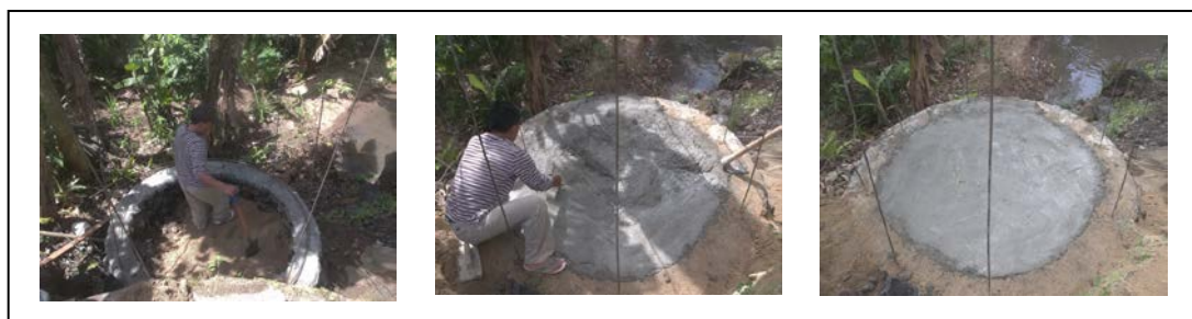
Gambar 2. Pembuatan Pondasi Digester Tipe fixed dome di Atas Tanah
