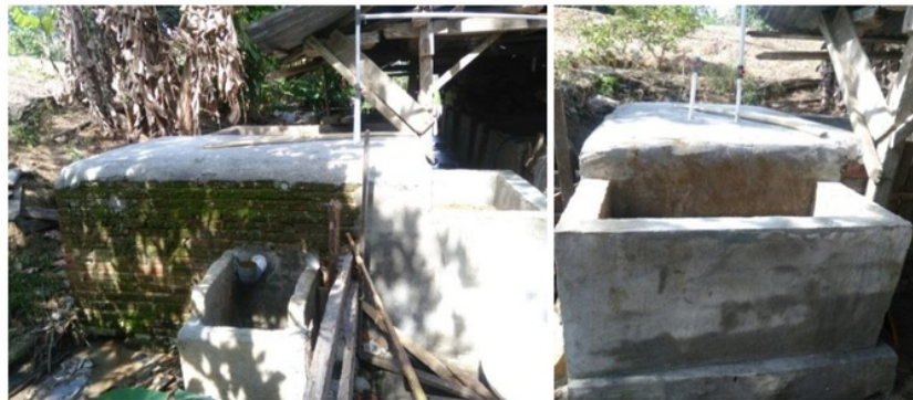
Gambar 2. a dan b. Digester biogas yang dibangun di desa Kosio
