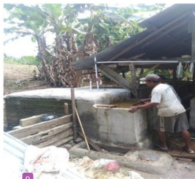
Gambar 4. Pencampuran kotoran ternak dan air dengan perbandingan 1:2
