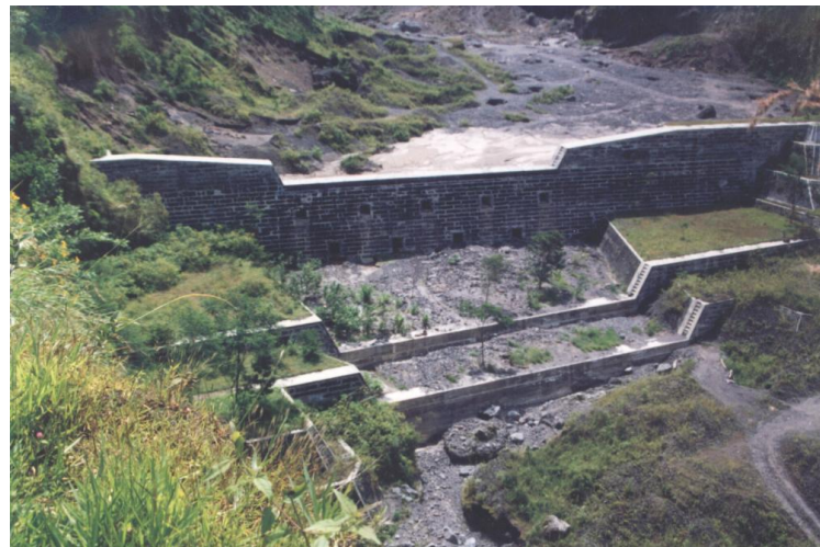
Gambar 8. DPS K.Gendol GE-D5 (tipe tertutup)
