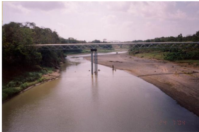
Gambar 8. Sedimentasi di hulu jembatan Bantar
