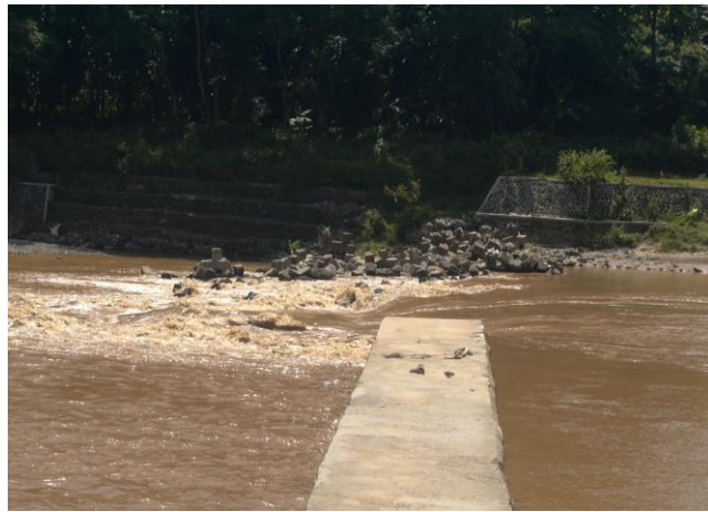
Gambar 1. Kerusakan struktur bangunan sungai
