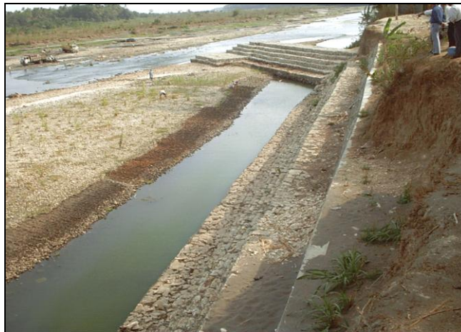
Gambar 4. Pemasangan talud sebagai upaya pengendalian banjir
