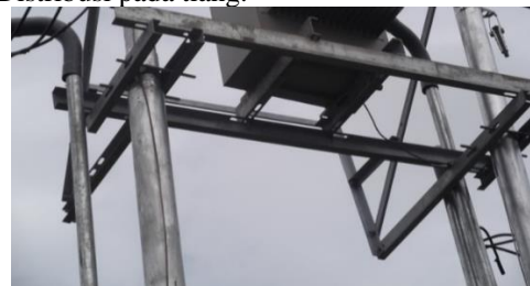
Gambar 2. 5 Dudukan Transformator
