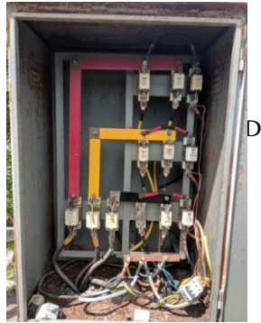
Gambar 2. 6 Panel hubung bagi tegangan rendah
