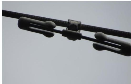
Gambar 3: Kondisi damper vibrasi terpasang
