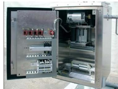
Gambar 10 PMS Mekanik PMS dengan Penggerak Motor
