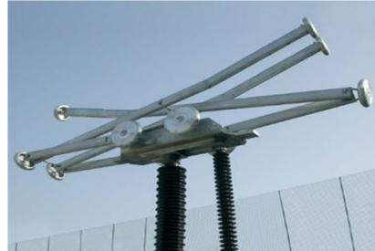
Gambar 8 Pemisah Pantograph
