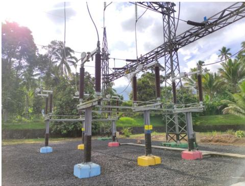
Gambar 1 Pemisah (*Disconnecting Switch*)
