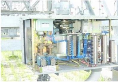
Gambar 11 PMS Mekanik PMS Tekanan Udara
