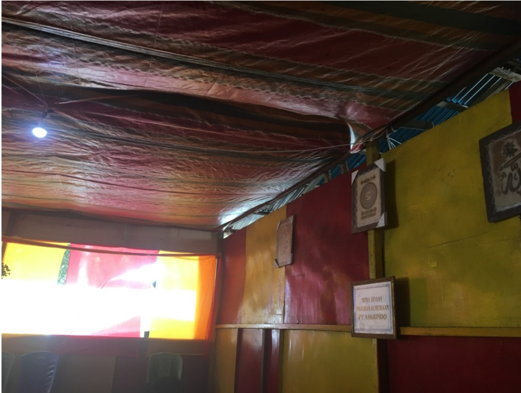
Gambar 8. Pemanfaatan solar luggage portable di mushola di Pulau Bunaken
