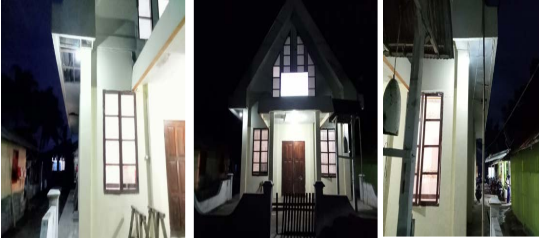
Hasil pemasangan lampu di teras gereja dengan sumber energi panel surya
