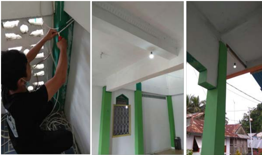
Pemasangan instalasi panel surya di Masjid Al-Muhajirin dan hasil pemasangan
