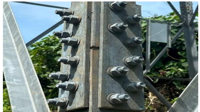
Gambar 13. Mur dan Baut (T094-T096)
