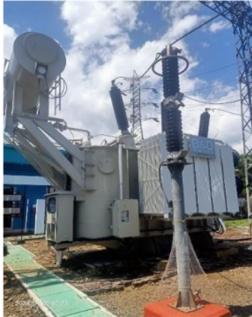
Gambar 3.2 Arrester ABB AB / PEXLIM Q 144-YV170E
