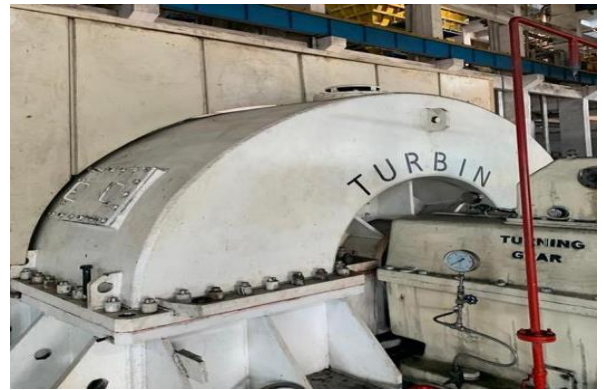
Gambar 3. Turbin Uap pada PLTU 2 Sulawesi Utara
