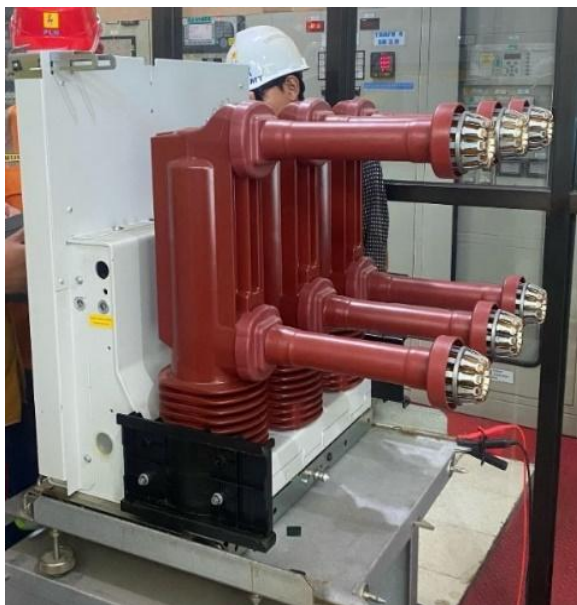
Gambar 2 Circuit Breaker 20 kV di GI Ranomuut
